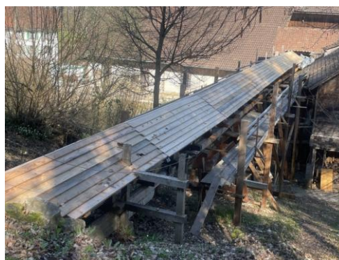
Der neue Kanal mit Dach /Witterungsschutz
